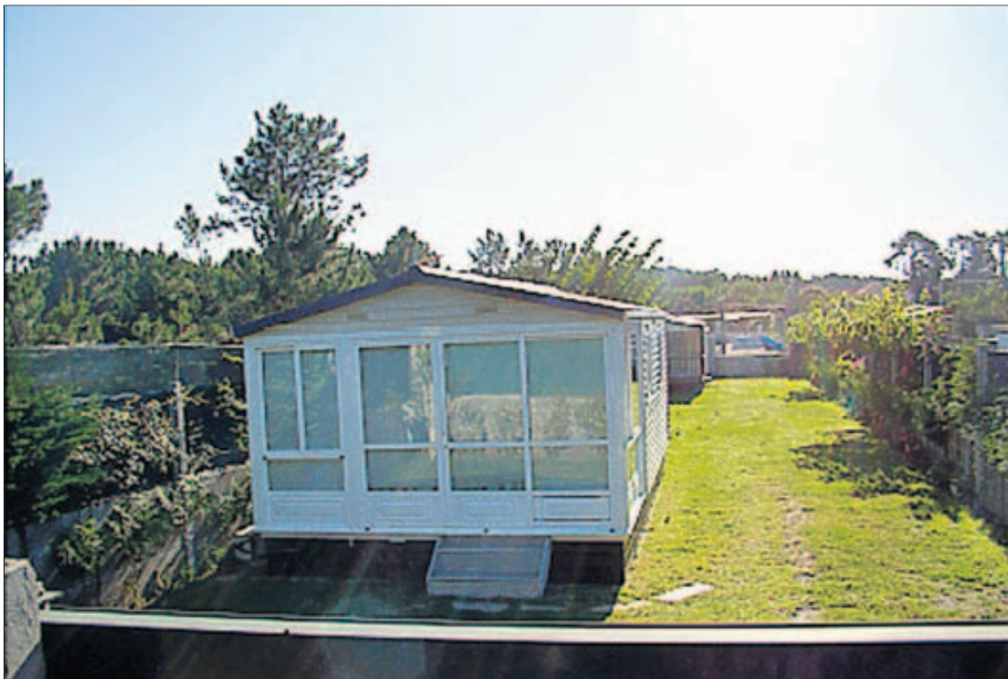
Una de las viviendas afectadas por la orden de demolición de la APLU. // FdV
