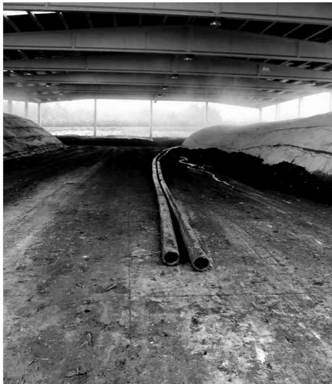
El residuo será descargado en una superficie pavimentada, con descarga a diferente nivel y bajo cubierta, con ventilación lateral gracias a los laterales abiertos. El almacenaje del residuo es temporal, procurando que no supere las 24 h para evitar problemas de olores.
