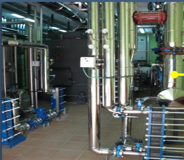
El excedente de energía de los paneles solares, se emplea para proporcionar aire acondicionado a un área del edificio, con una máquina de absorción de 70kW
