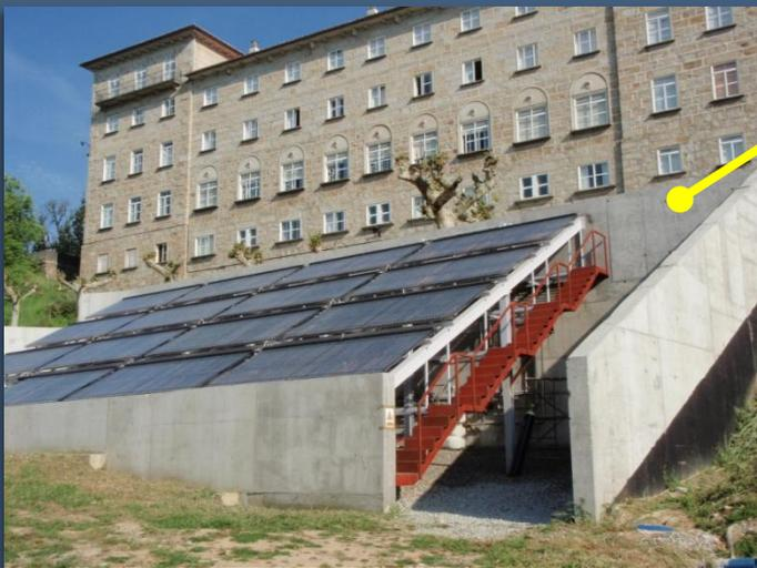
Paneles solares de tubo de vacío Viessmann, proporcionan agua caliente sanitaria en verano y calor residual para alimentar la refrigeración por absorción
