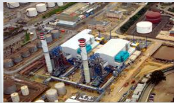
C.C.C.G. NUEVA GENERADORA DEL SUR
