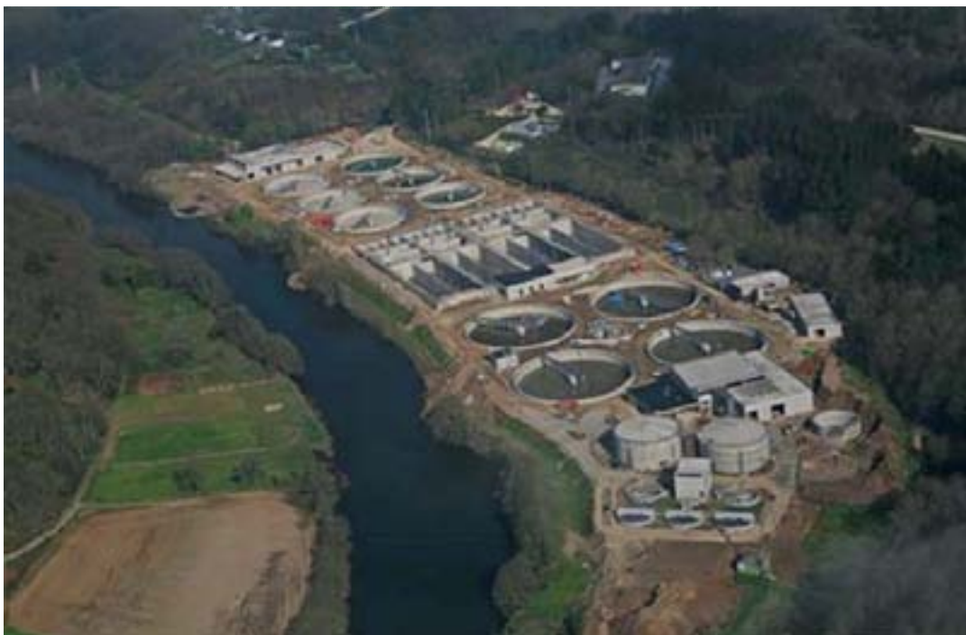
Nueva EDAR de Lugo
